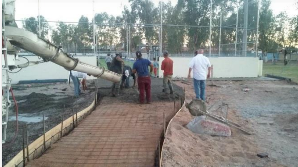
COLADO DE ANDADOR A HOCKEY
