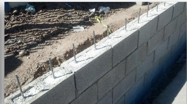
MURO DE CONTENCIÓN
