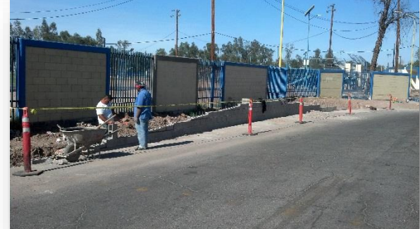
MURO DE CONTENCIÓN
