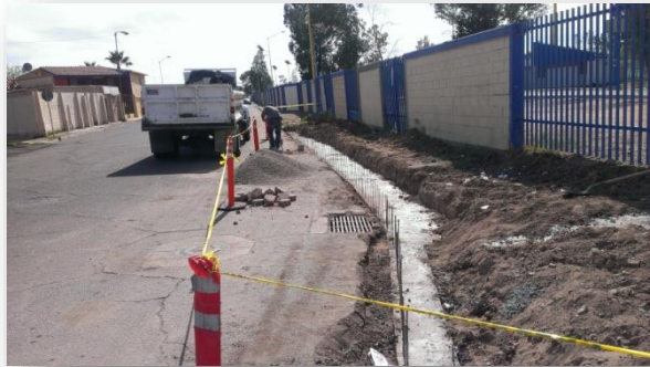
ZAPATA DE MURO DE CONTENCIÓN
